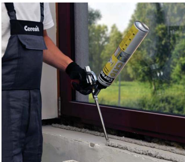
Klijų taikymas klijuojant palanges
