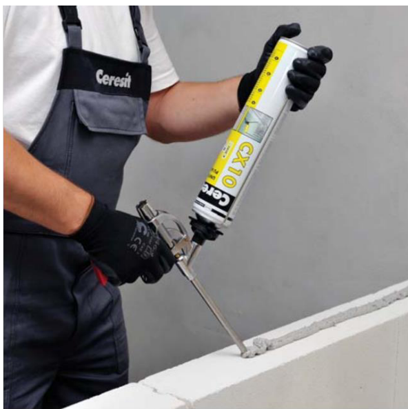
Klijų paskleidimas jungiant aktytojo betono blokelių
