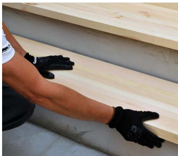
Laipto pakopos pritaikymas ir jos pritvirtinimas
