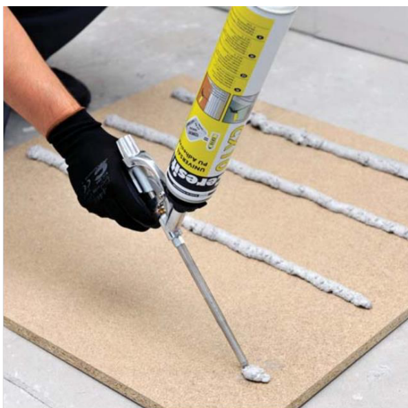
Klijų paskleidimas ant plokštės
