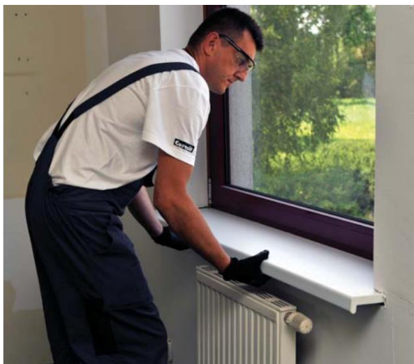
Palangės įstatymas ir jos pritvirtinimas
